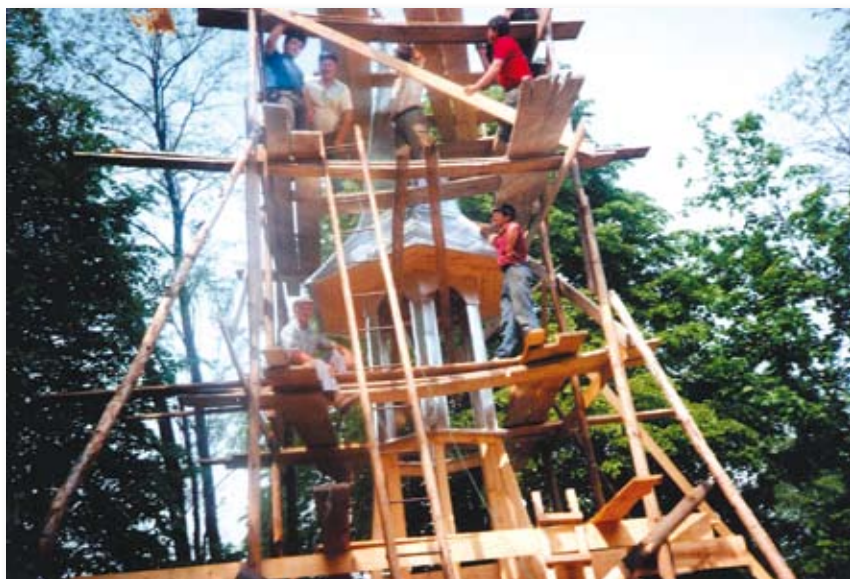
Montaż wieży na ziemi
