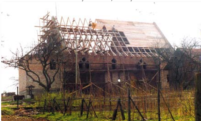
Budowa kościoła w Przybówce na murach starej szkoły
