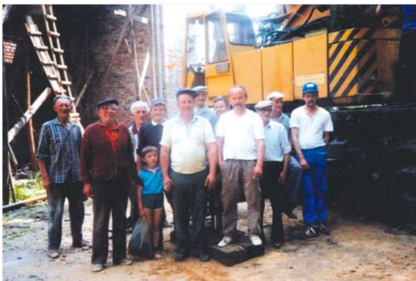
Montaż wieży na kościele
