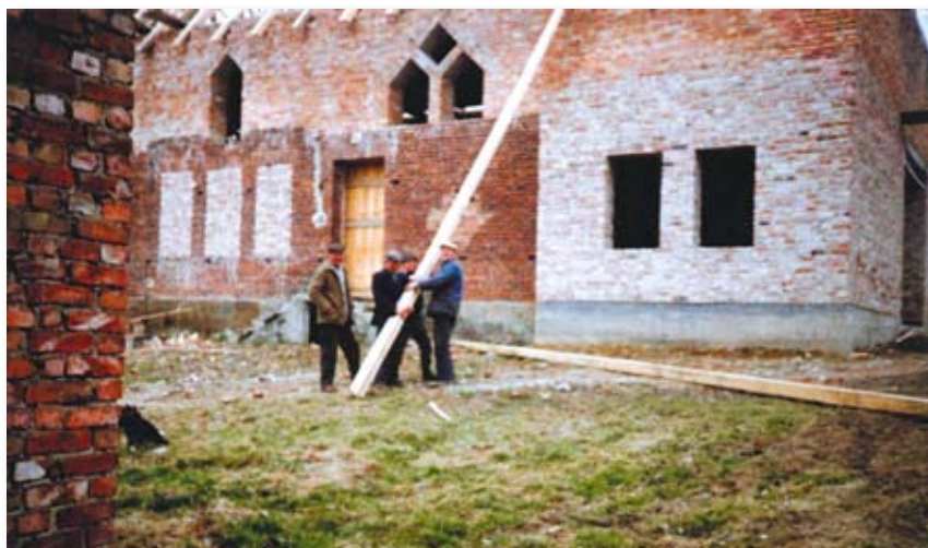
Budowa dachu na kościele
